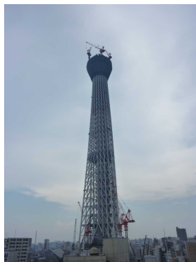
建設中の東京スカイツリー (2010年7月現在)
